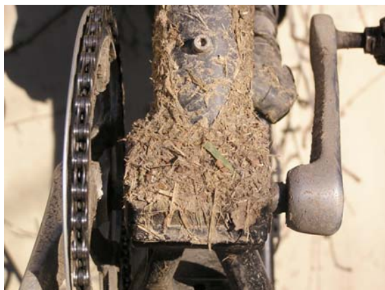
Verschmutzter Rahmen im Bereich der Exzenter-Spannschrauben
